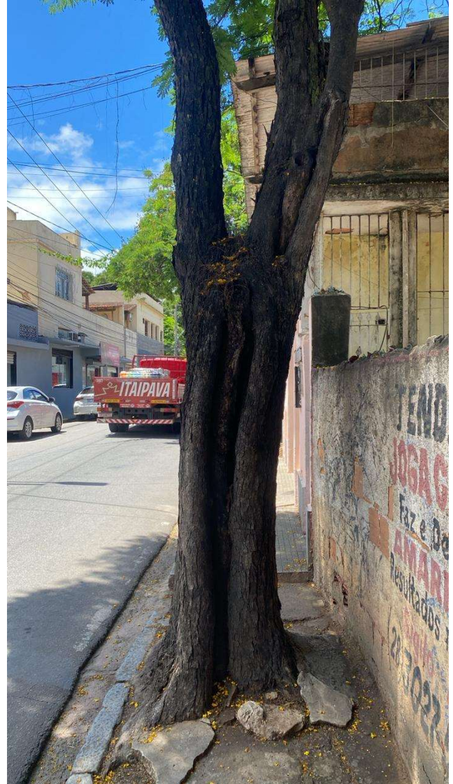
Figura 5. Caule com presença de fendas e injúrias/lesões. Observa-se podridão de parte do lenho. Risco de queda.
